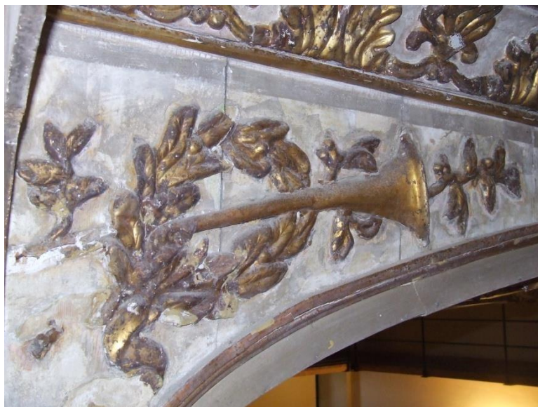
04 - Particolare degli stucchi dell'arcata del boccascena
